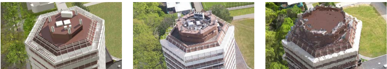
Abbildung 23: Detail-Gegenüberstellung des Wohnkomplexdaches der Sportschule Wedau aus Perspektive 2
